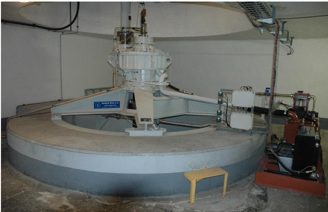
Obr.10 Pohled na Kaplanovu turbínu ve spodní části strojovny
