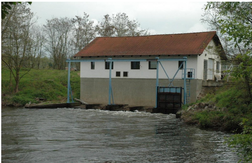
Obr.12 MVE Týnec nad Labem (výtok z elektrárny)
