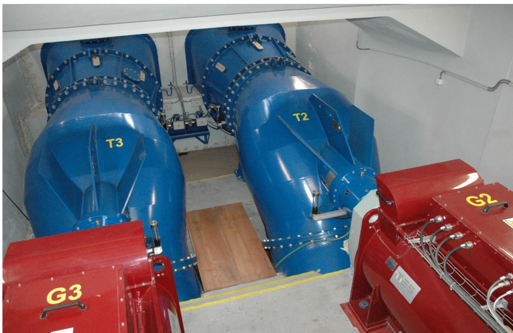
Obr.18 Strojovna MVE Kolín - pohled na dvě ze sedmi Kaplanových turbín
