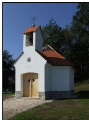
Obr. 2: Kaplička s vnitřním prostorem (Petrova Hůrka pod Kletí) (earch.cz, 2017).
