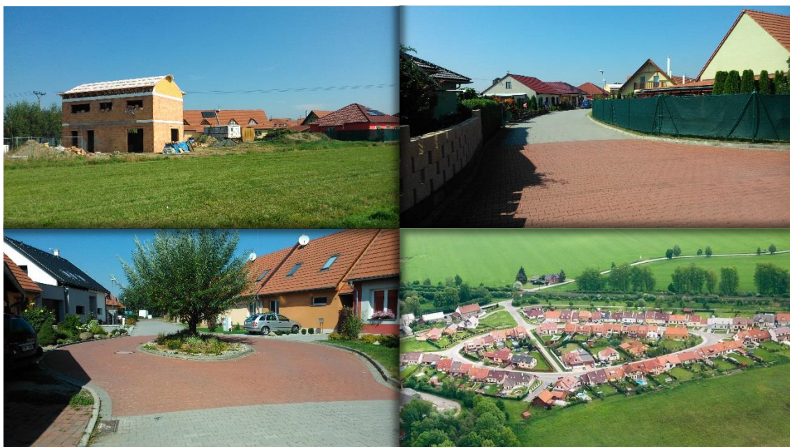
Obr. 16 Nová zástavba v Hlušovicích
