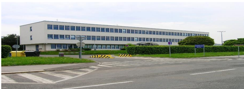
Obr.č.1 – Budova úřadu pro civilní letectví 29
