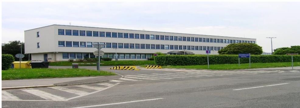
Obr.č. 1 – Budova úřadu pro civilní letectví 29
