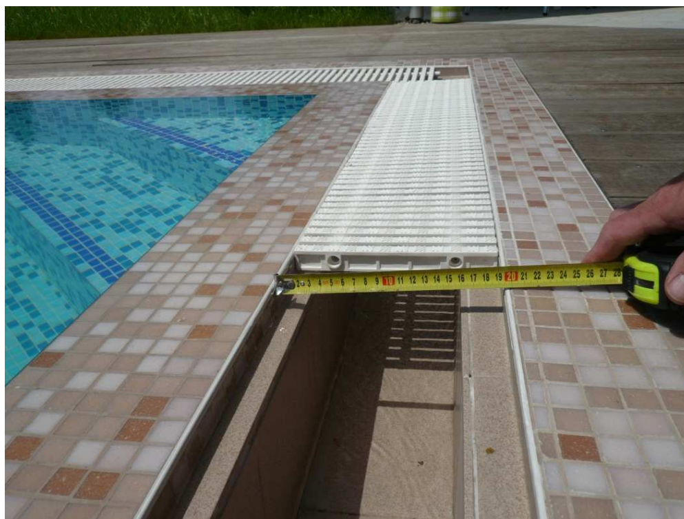
Obrázek č.6 – detail přelivného žlábků Zdroj: fotodokumentace Sportakcent
