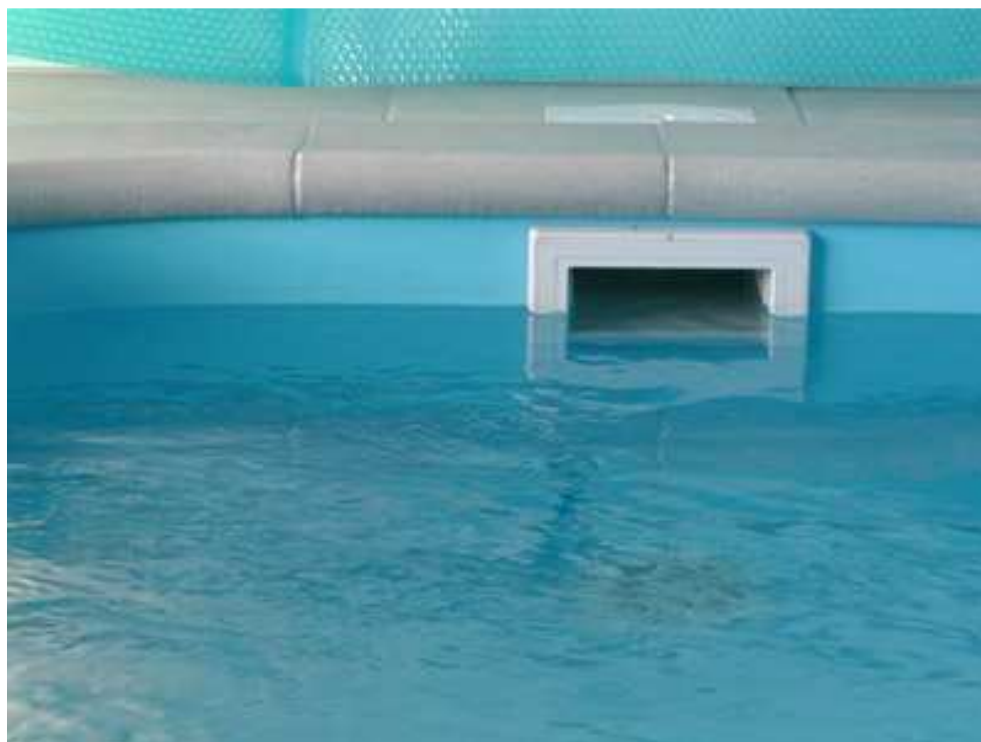
Obrázek č.5 – detail skimmeru Zdroj: http://www.bazenypopp.cz/ , 2009
