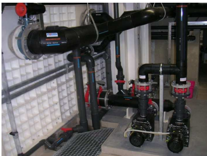
Obrázek č. 7 – detail napojení akumulaci jímky. Zdroj: fotodokumentace Sportakcent
