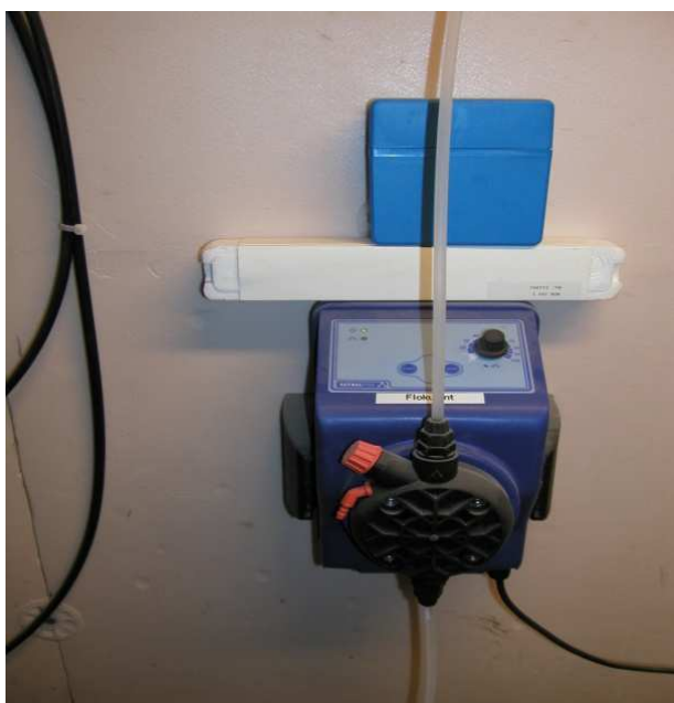
Obrázek č. 15 – dávkovací čerpadlo koagulátu Zdroj: fotodokumentace Sportakcent
