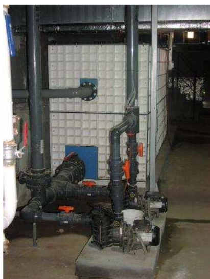
Obrázek č. 8 – akumulaci jímka Zdroj: fotodokumentace Sportakcent
