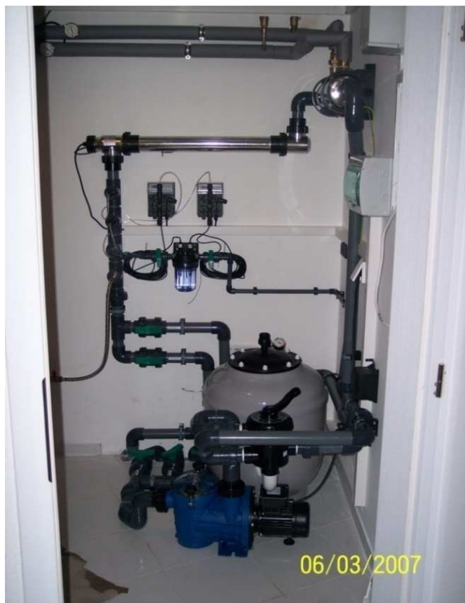
Obrázek č.11 – nízký filtr a cirkulační čerpadlo pro malý rodinný bazén Zdroj: fotodokumentace Callistopool
