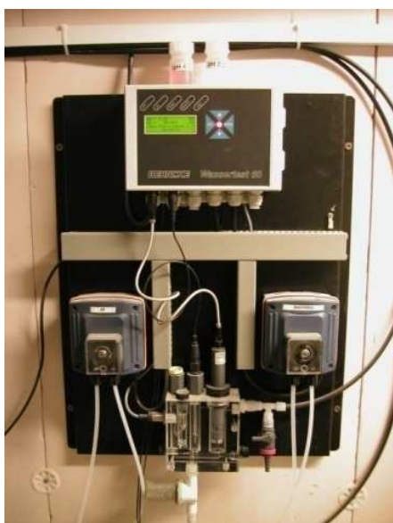
Obrázek č.13 – automatické měřicí zařízení pro kontrolu vody. Zdroj – fotodokumentace Sportakcent
