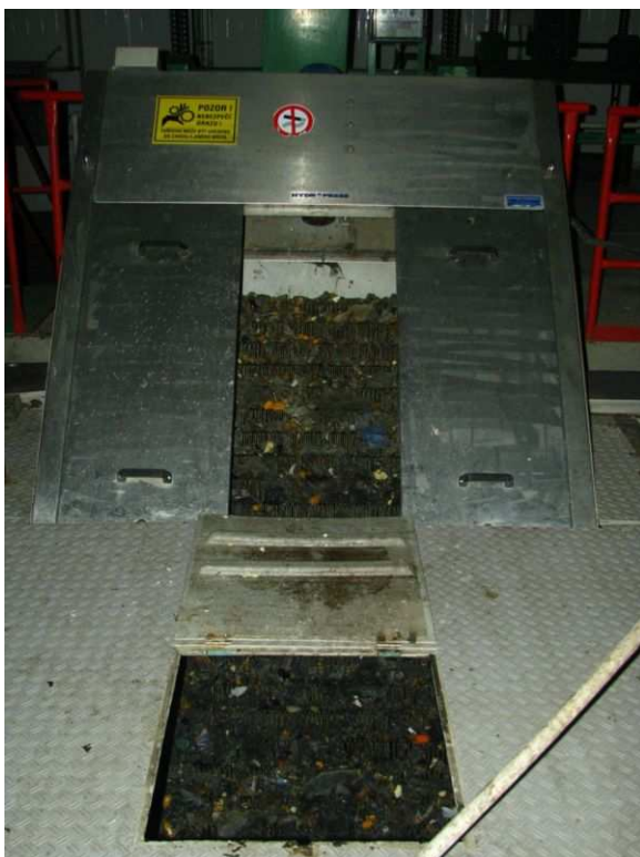
Obr. 1: Jemné česle na ČOV Olomouc
