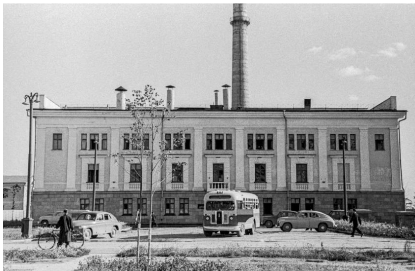
Obr. 3.1 Jaderná elektrárna v Obninsku [28]
