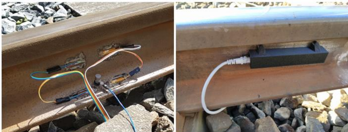
Obrázek 58: První instalace MFC na železniční trať, vlevo první lokalita v roce 2019, vpravo druhá lokalita v roce 2020
