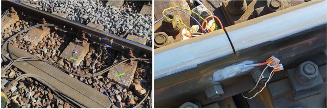
Obrázek 67: Monitorování lepeného izolovaného styku
