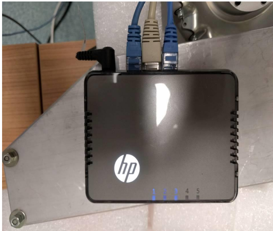
Obr.71 Switch prepájajúci kontrolér IRC5, PLC X20CP1084 a osobný počítač
