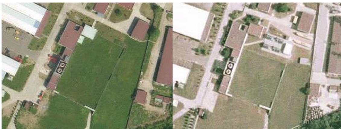
Obrázek č. 11: Porovnání stavu objektu v letech 1997 a 2003
