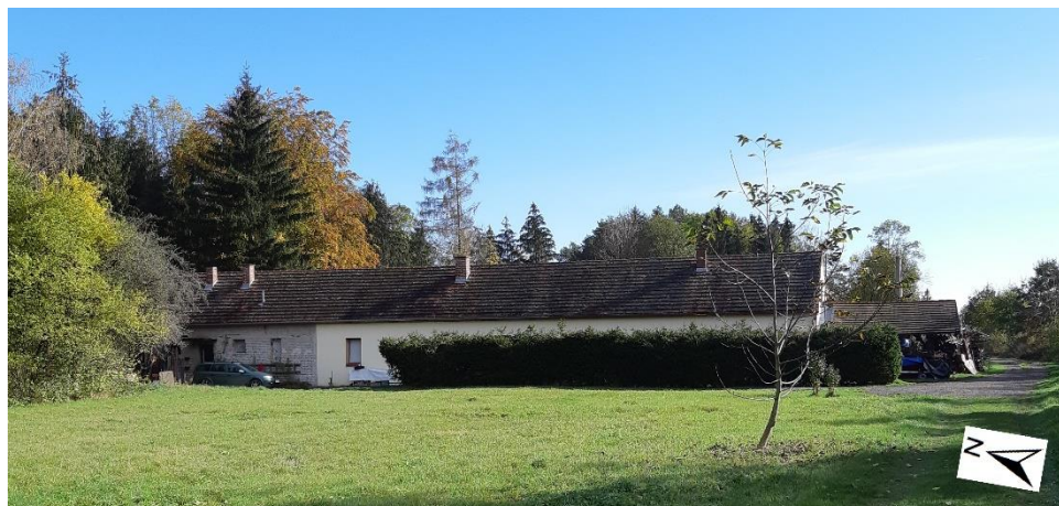
Tabulka 85: Pohled na dochovanou budovu (dnes rodinný dům) ve Svobodných Dvorech, bod na mapě 59.
