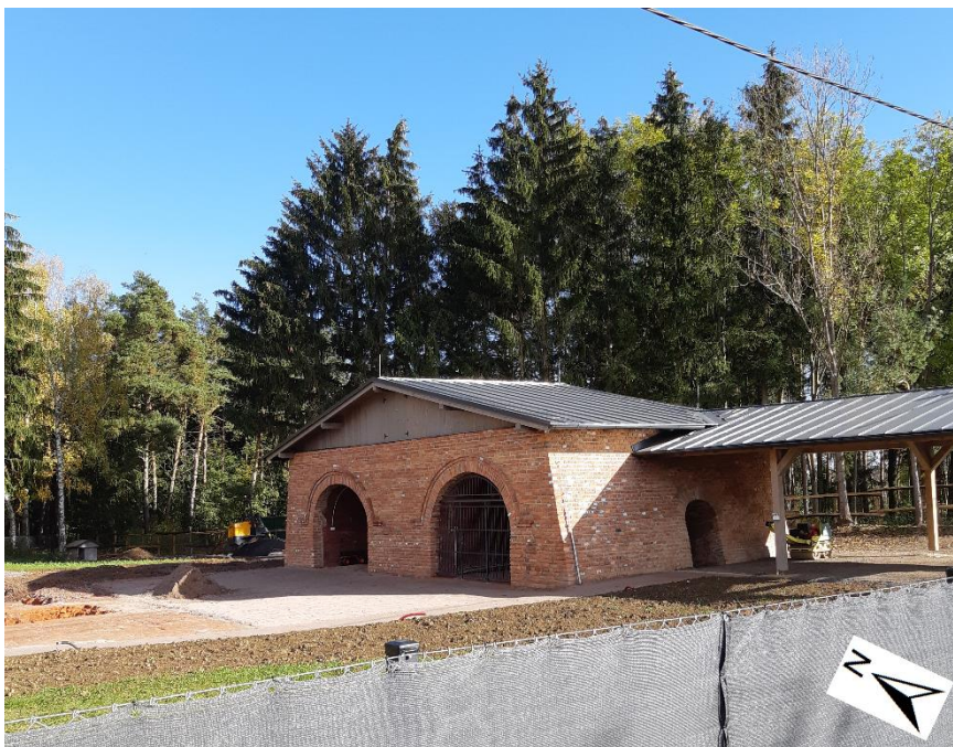
Tabulka 84: Pohled na část dochované kruhové pece ve Svobodných Dvorech, bod na mapě 53.
