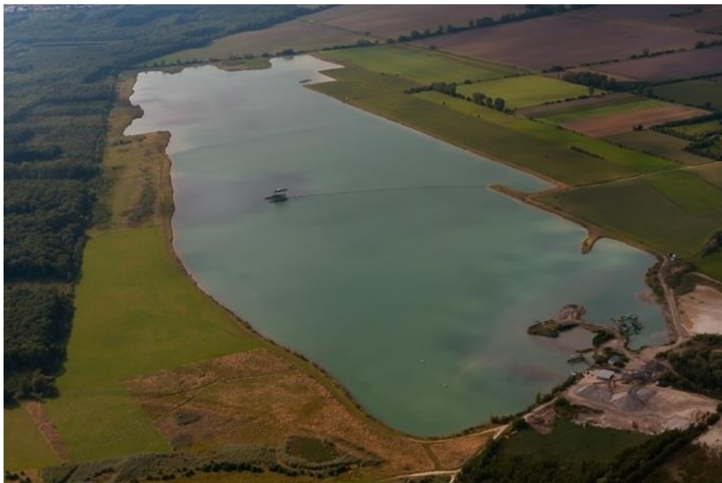
Obrázek 15: Letecký snímek štěrkopískovny [18]
