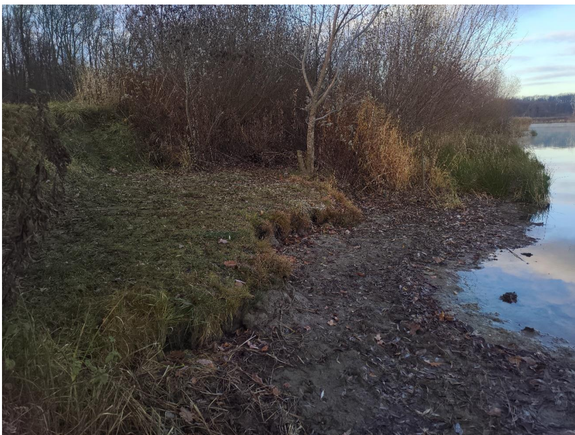
Obrázek 20: Abrazní sruby na zájmovém úseku [L. Tomšej, 2021]
