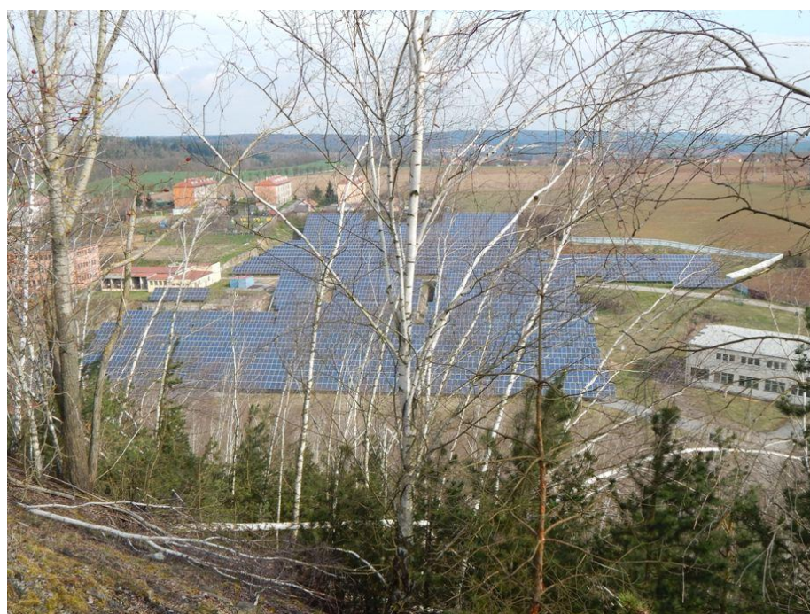
Fotovoltaická elektrárna v areálu dolu Jindřich II (duben 2015)
