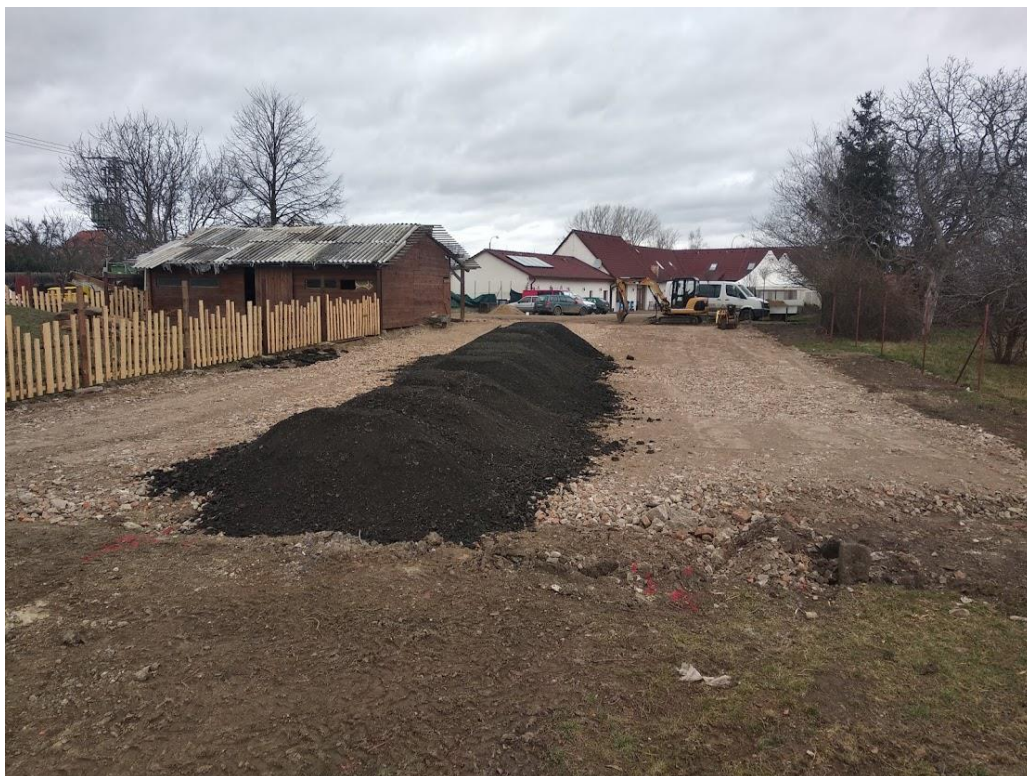
Příloha 5 Příprava svrchní vrstvy parkoviště (zdroj: vlastní)
