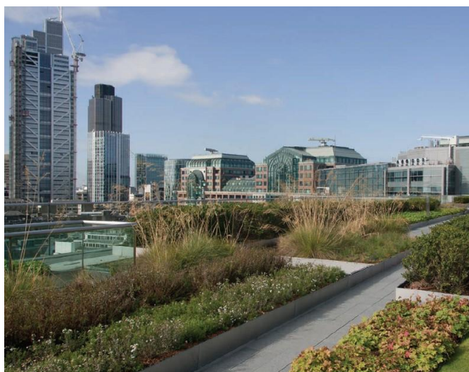
Obrázek 12 Intenzivní střešní zahrada (zdroj: Ciria 2015)
