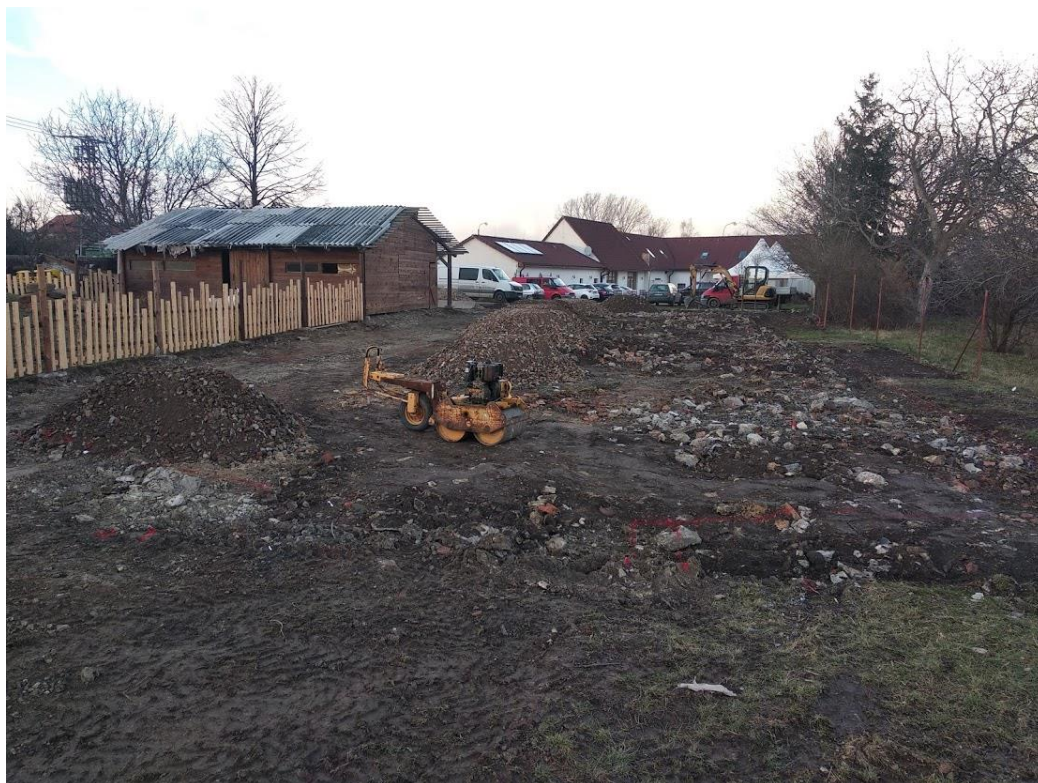
Příloha 4 Příprava podkladové vrstvy parkoviště (zdroj: vlastní)
