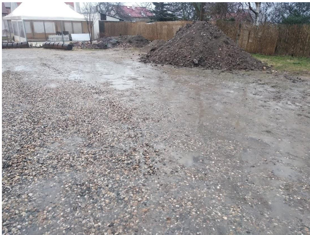
Příloha 3 Zhutněný nepropustný povrch před rekultivací (zdroj: vlastní)
