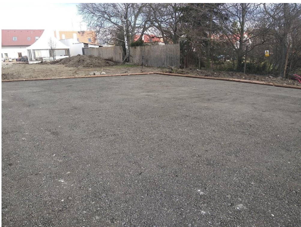
Příloha 6 Dokončení úprav parkoviště (zdroj: vlastní)
