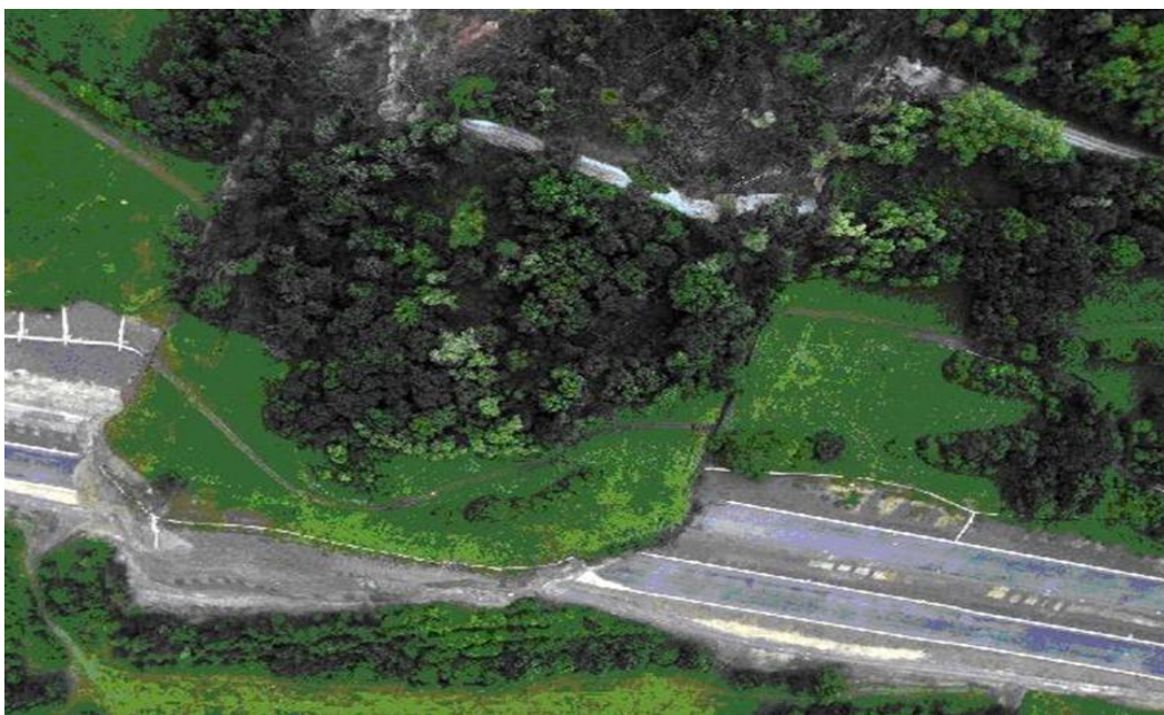
Obr. č.5: Sesuv půdy u Litochovic v červnu 2013(převzato z http://podkubackou.webnode.cz/a7-zastaveni/sesuv-pudy-na-d8-u-litochovic/ )
