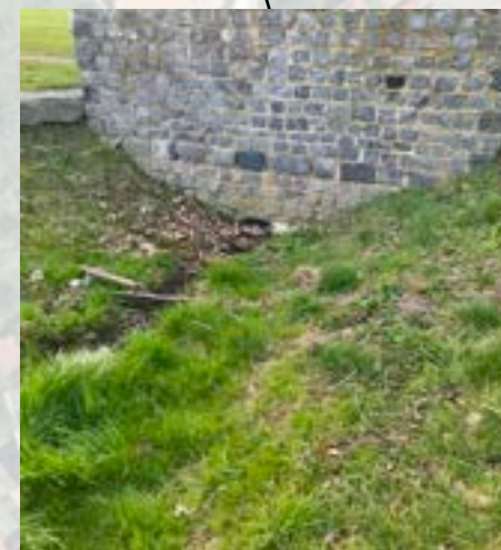
Obr. 103 Vyústění potrubí pod mostem, zdroj: autorka práce
