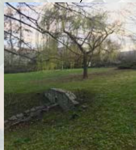
Obr. 100 Vyústění potrubí do horní nádrže, zdroj: autorka práce
