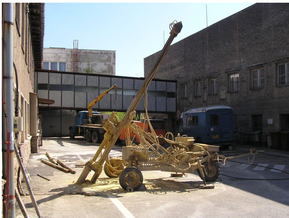
Obrázek č. 31: Vrtné práce v areálu podniku (SEKM 3, ©2021)
