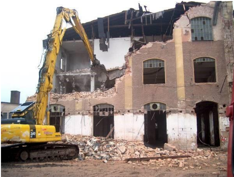
Obrázek č. 10: Demolice vegetabilního objektu (VZ Ekomonitor, @2021)
