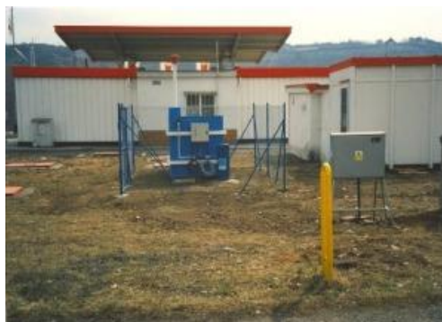
Obrázek č. 19: Sanační čerpání podzemní vody (ATE ČR, ©2021)
