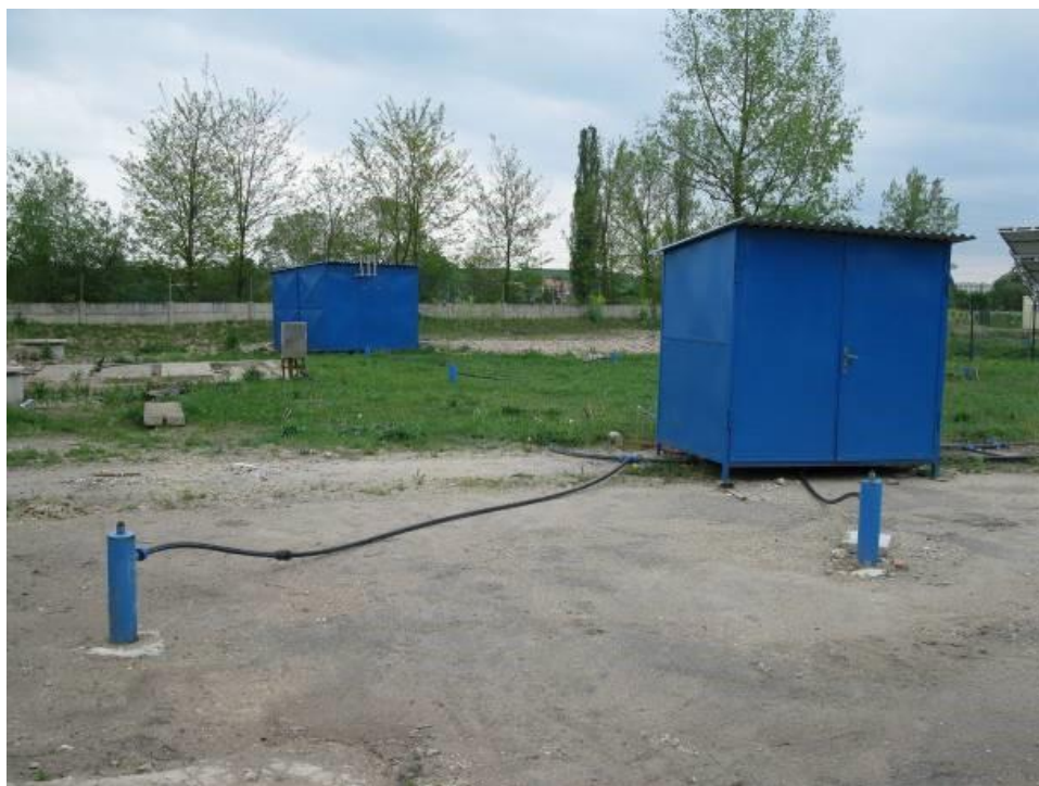
Obrázek č. 30: Aplikace ventingu v prostoru bývalého skladu hořlavín (VZ Ekomonitor, ©2021)
