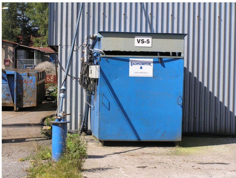
Obrázek č. 12: Ventingová stanice použitá při sanaci areálu podniku (SEKM 3, ©2021)
