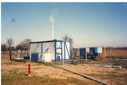
Obrázek č. 18: sanační čerpání podzemní Vody (ATE ČR, ©2021)
