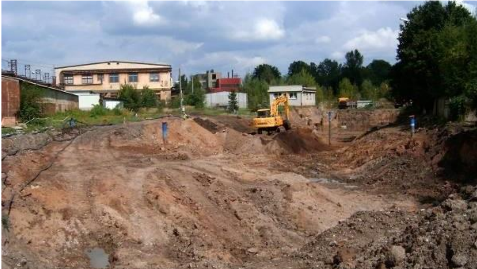
Obrázek č. 9: Odtěžba kontaminované zeminy v areálu hlavního závodu (VZ Ekomonitor, ©2021b)
