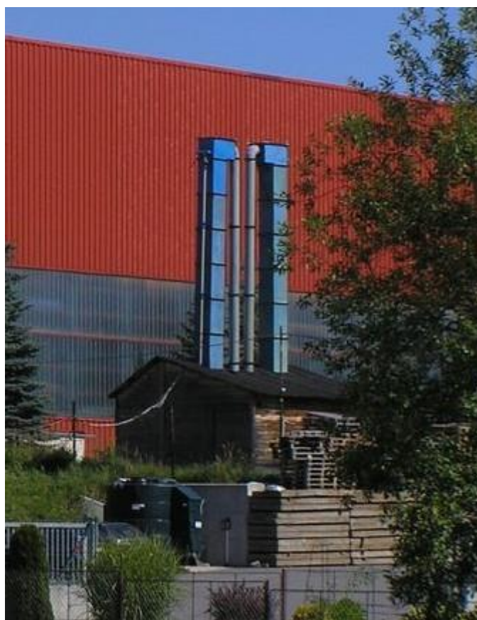
Obrázek č. 32: Sanační věž v areálu podniku (SEKM 3, ©2021)
