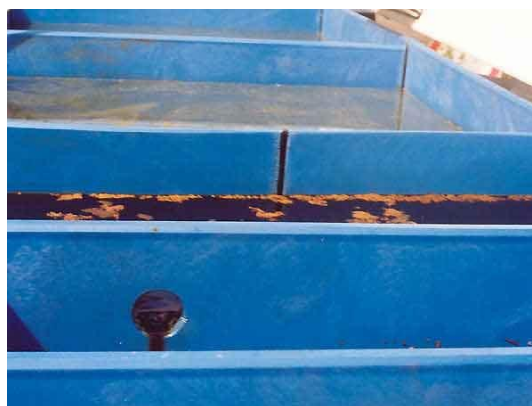
Obrázek č. 23: Gravitační odlučovač, sběr odloučené fáze RL (Lidařík, ©2021)
