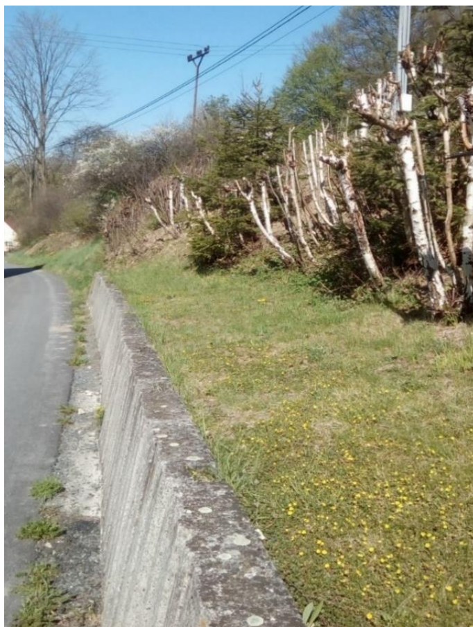
Obrázek 22: zpevňující betonová zídka na okraji svahu v ploše č. 47, mapovaný čtverec Sýk 29. Vlastní foto 21. 4. 2019
