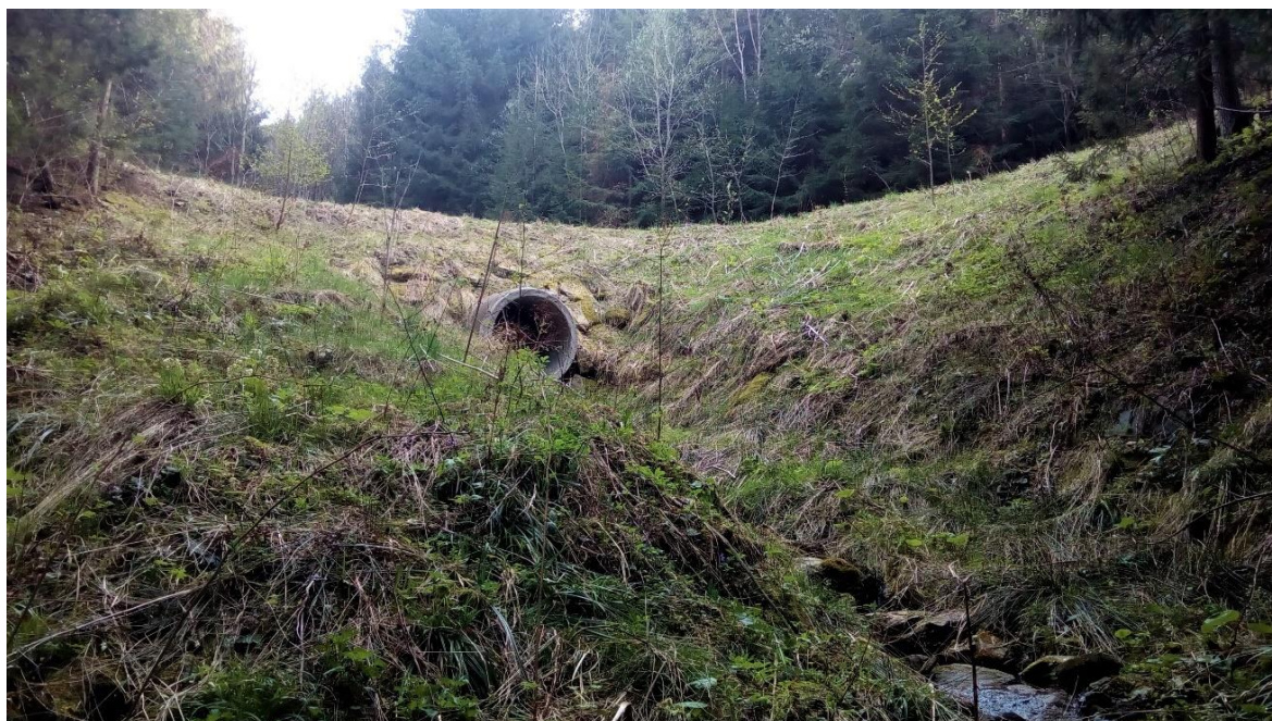
Obrázek 27: vyústění vodní roury, do které je sveden Veselský potok pod zpevněnou lesní cestou v místě mapovaného čtverce Ves 34. Vlastní foto, 20. 4. 2019
