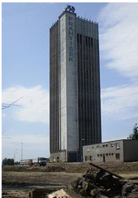
Obrázek 10 Těžní věž skipu s věžovou strojovnou
