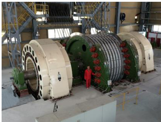
Obrázek 5 Osmilanový těžní stroj s třecím kotoučem
