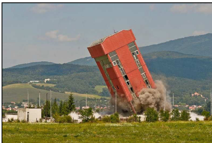
Obr. č. 3. 1 Likvidácia šachty Jamy G pre sprístupnenie ťažby
