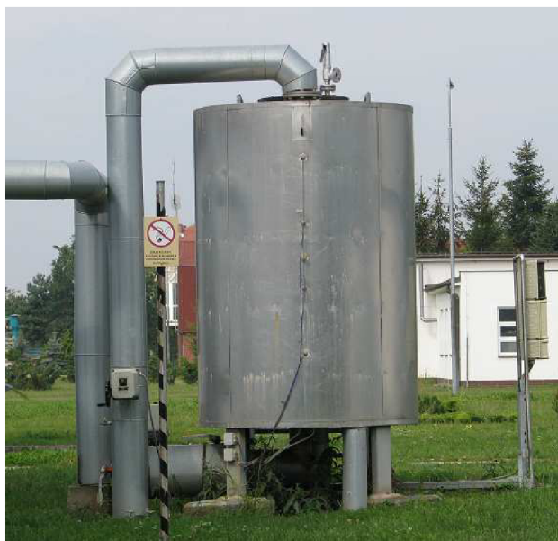
Obr. 6.0 Odsiřovací jednotka Suloff - ČOV Prostějov
