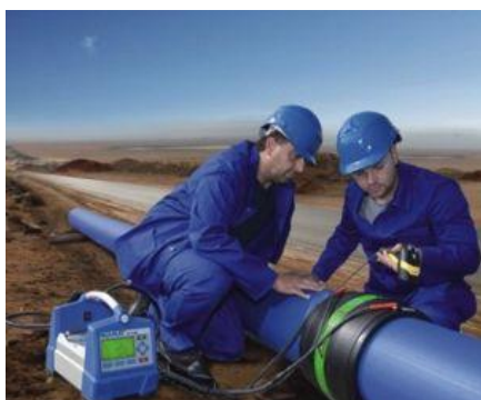
Obr. 18 - Svařování potrubí Pe
