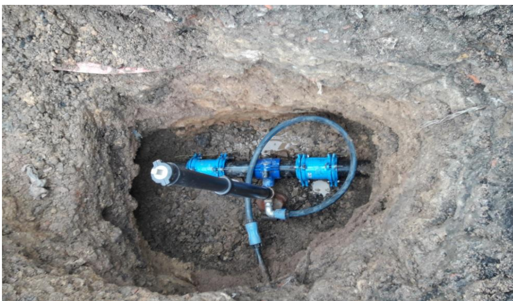
Obr. 41 – Potrubí po opravě
