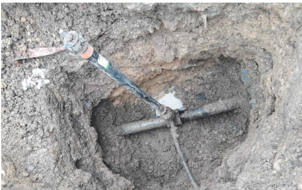
Obr. 41 – Potrubí po opravě
