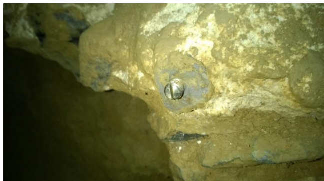
Obr. 3.6 Stabilizace měřického bodu nerezovým šroubem
