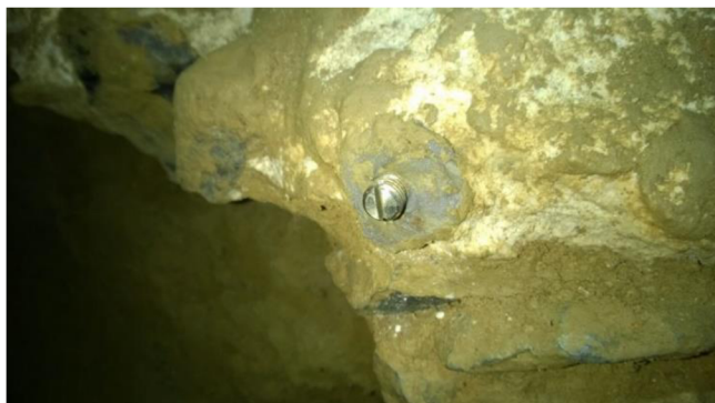
Obr. 3.6 Stabilizace měřického bodu nerezovým šroubem
