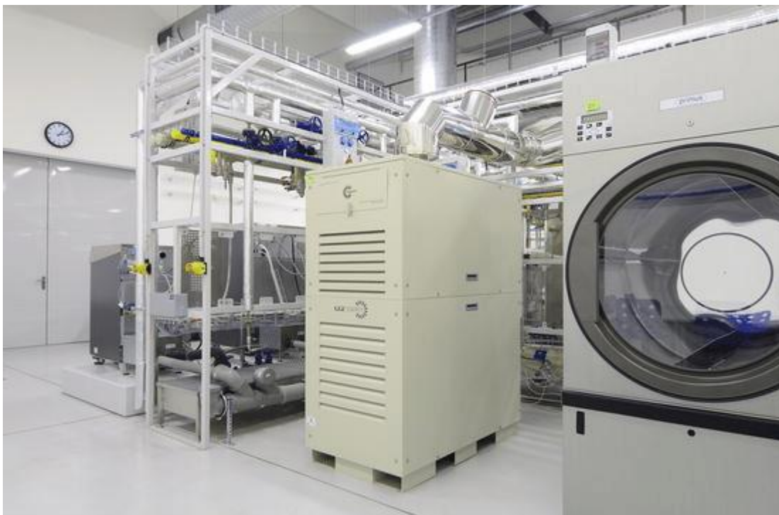
Obr. 1 Mikroturbína Capstone C30 integrována do infrastruktury LENP
