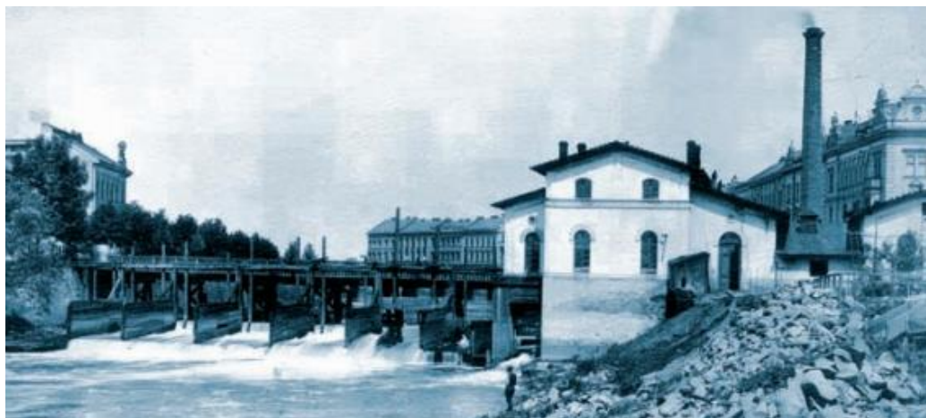
Obrázek 10: Pevnostní jez Hučák na Labi s budovou městské vodárny, 1908
