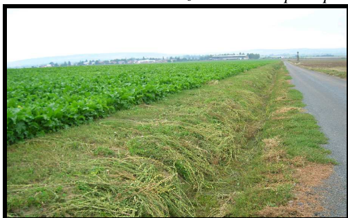
Obr.č.4: PC C5 Po realizaci cestního příkopu
