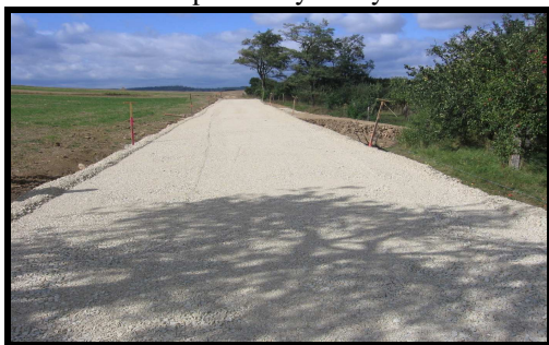
Obr.č.18: C 5 – průběh výstavby
