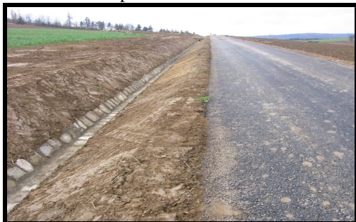
Obr.č.22: Příkop u části C3
