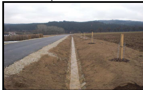
Obr.č.23: Příkop u části C3
