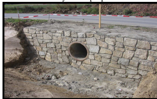
Obr.č.19: C 5 – výstavba propustku
