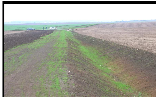
Obr.č.13: C2/2 SP-C162 v době realizace
