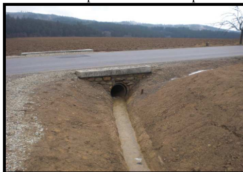
Obr.č.20: Propustek v části C 5 v provozu
