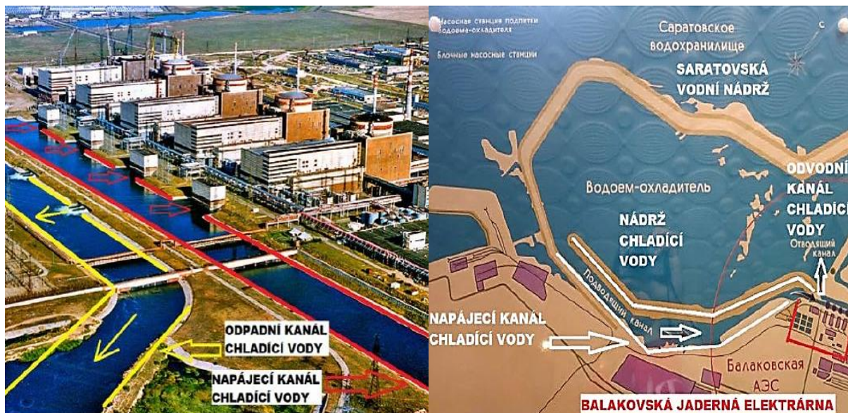
Obr. 12 Prívod a odvod chladiacej vody z a do rieky Volhy; Balakovská jadrová elektrárň [13]
