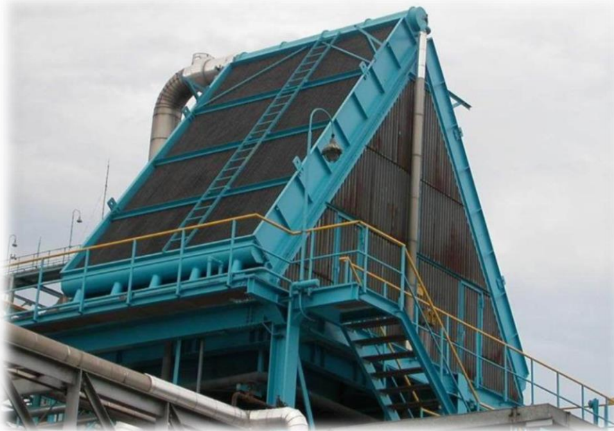
Obr. 5 Vzduchom chladený kondenzátor [7]
