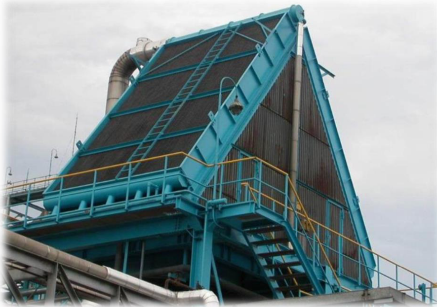
Obr. 5 Vzduchom chladený kondenzátor [7]
