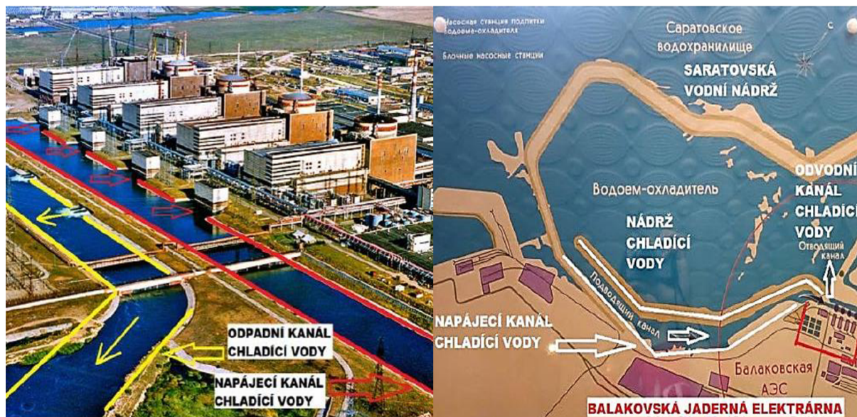
Obr. 12 Prívod a odvod chladiacej vody z a do rieky Volhy; Balakovská jadrová elektrárň [13]
