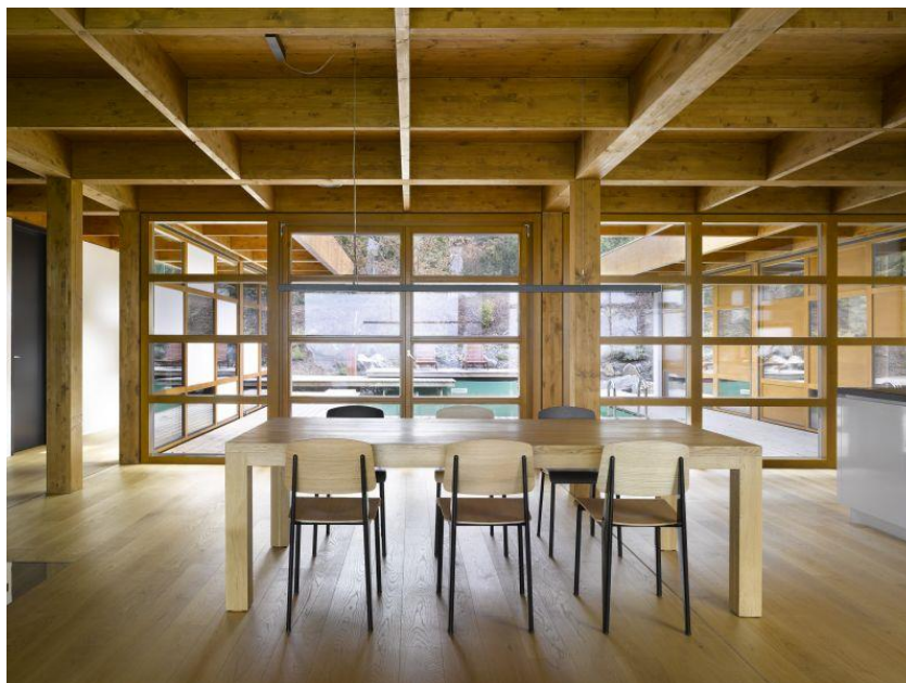
Obr. 9 - Interiér budovy postavené metodou těžký dřevěný skelet (Dřevo a stavby.cz, 2022)
