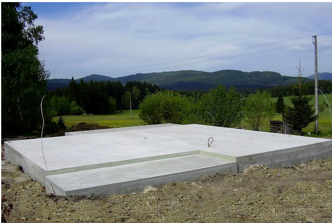
Obr. 15 - Pravá základová deska ze železobetonu (Dřevo a stavby 2018)
