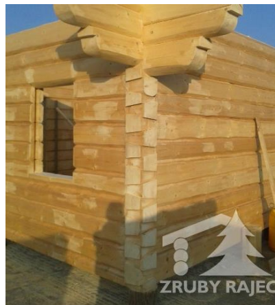
Obr. 2 - rohový spoj pro roubenku (Srubby Rajec, 2023)
