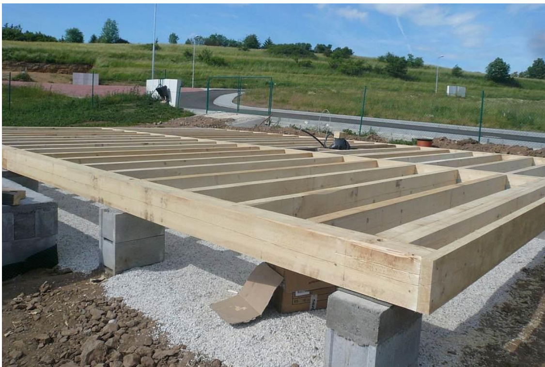
Obr. 16 - Základové patky s dřevěným základovým roštem (Dřevo a stavby 2018)
