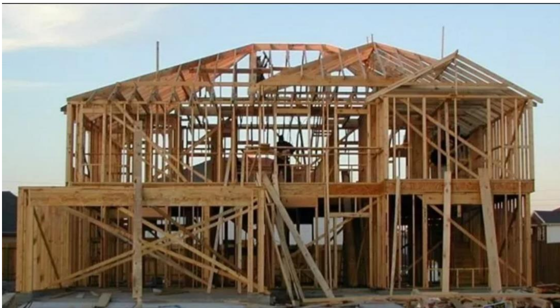
Obr. 7 - Ukázka výstavby metodou 2by4 (Dřevostavitel, 2012)
