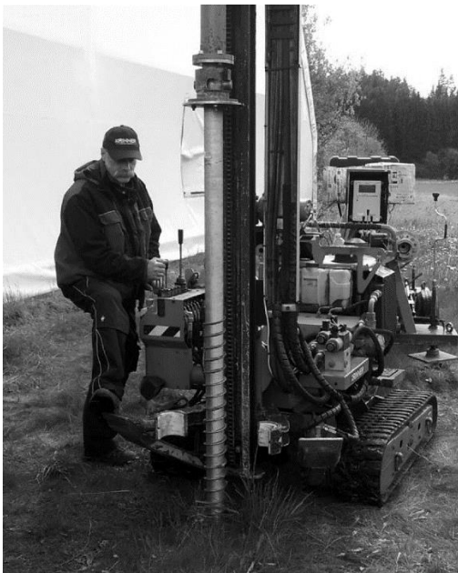
Obr. 17 - Zemní vrt připravený k zavrtání do podlaží (Kubečková, Kubeček, 2016)
