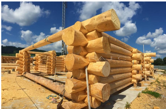
Obr. 1 - rohový spoj pro srub (Srubby Rajec, 2023)
