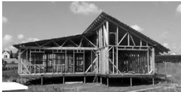
Obr. 18 - Hrubá stavba založená na dřevěném rámu podloženým zemními vrty (Kubečková, Kubeček, 2016)
