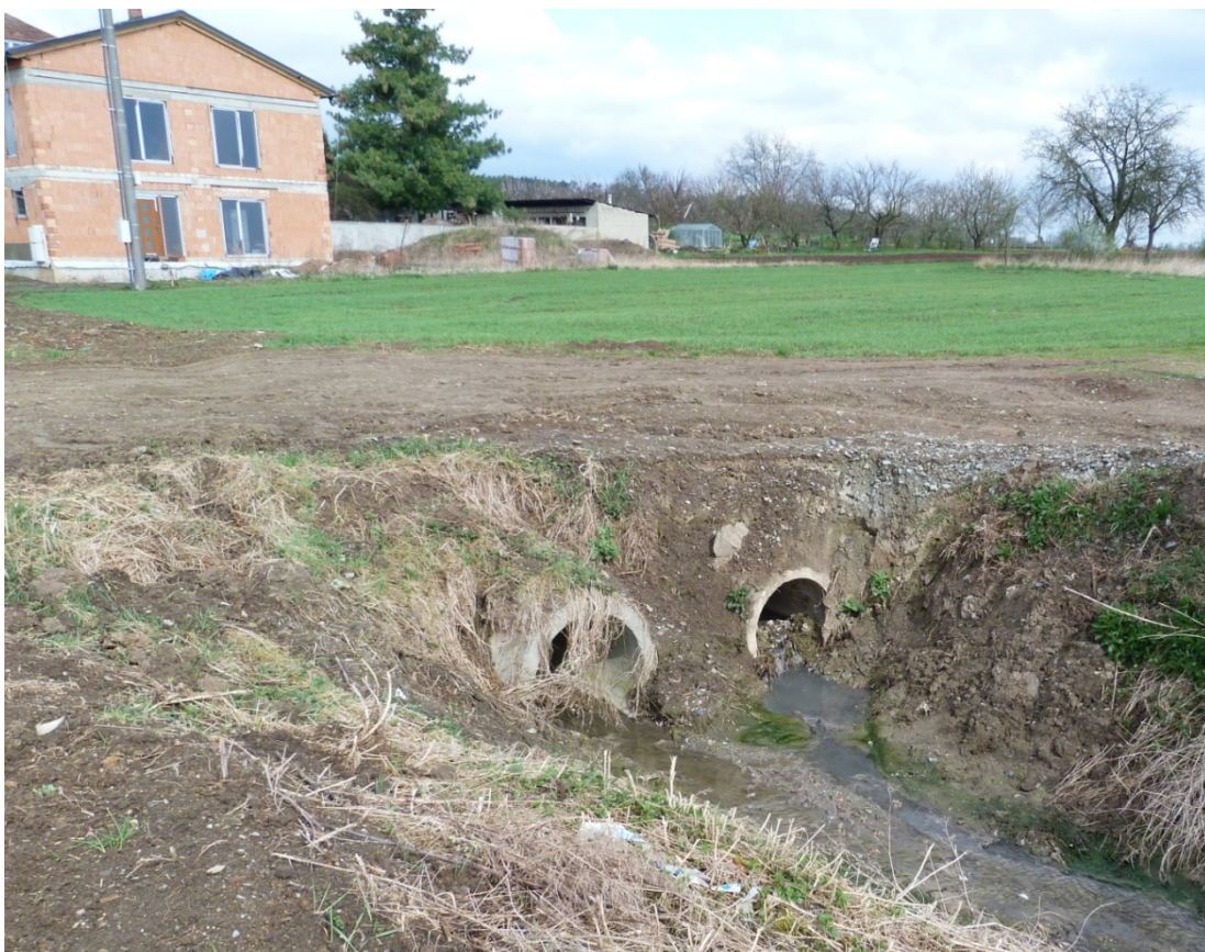
Obr. 3-1 Vyústění stávající kanalizace do otevřeného koryta [9]
