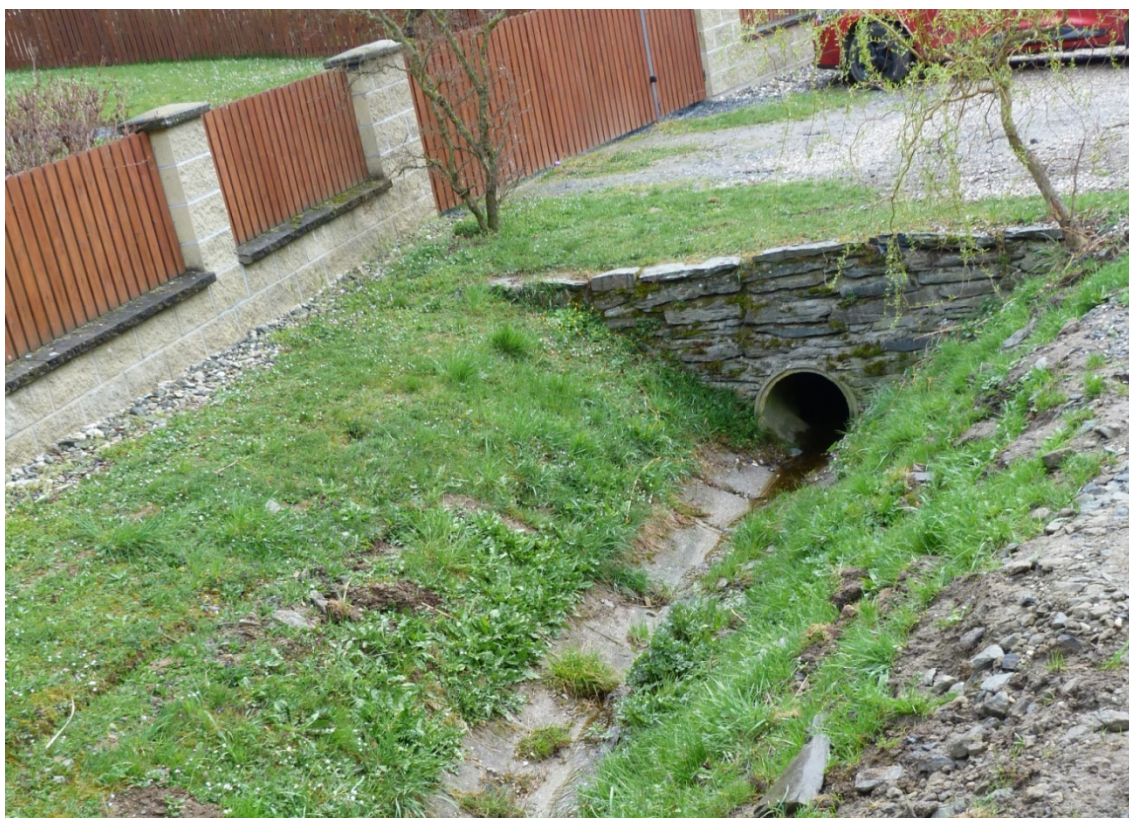
Obr. 2-6 Zatrubnění toku na vstupu do intravilánu [9]
