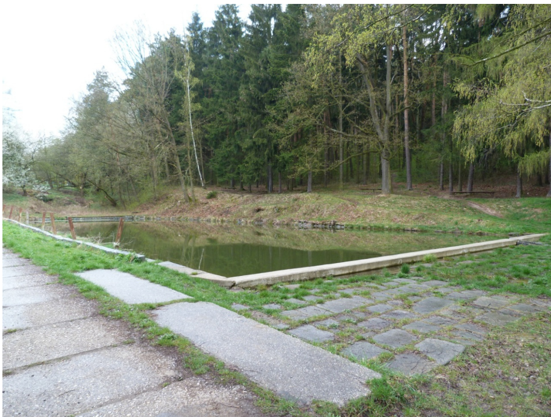
Obr. 2-5 Pohled na požární nádrž [9]
