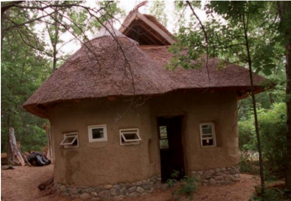
Obrázek 1: K postavení tohoto domu bylo potřeba 175 slaměných balíků. (Farrell, 2011)
