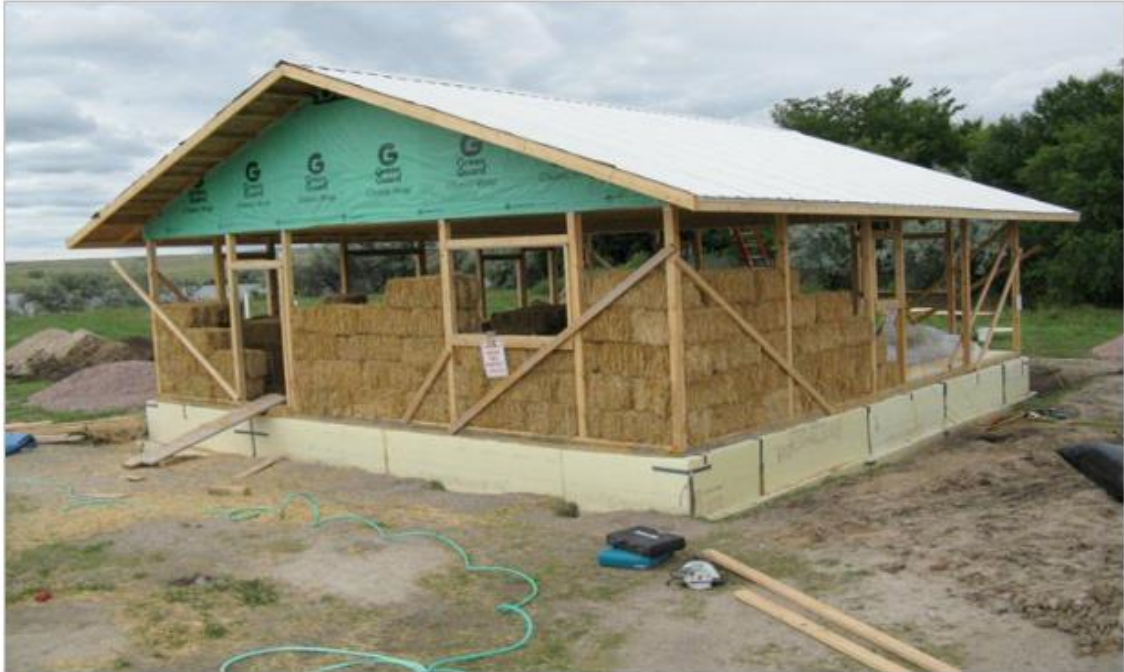
Obrázek 6: Ukládání slaměných balíků (www.organica.name)
