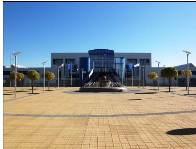
Obr. 27 Geometricky řešený reprezentativní prostor před vstupem do budovy je zpevněn betonovou dlažbou a jako dominantní prvek zde figuruje žulová fontána
