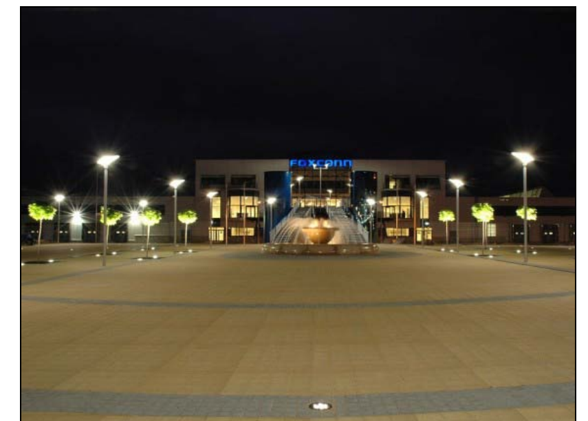
Obr. 31 Noční nasvícení vstupního prostoru s fontánou, uprostřed níž je otáčející se koule, která je nadnášena proudem vody
