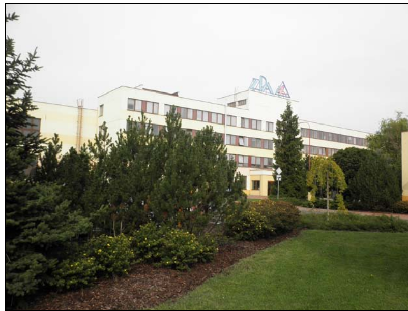
Obr. 21 Pohled na ústřední (administrativní) budovu areálu skrze keřové výsadby, které lemují rozlehlou travnatou plochu
