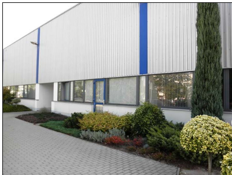
Obr. 11 Detail výsadeb podél hlavní budovy, které mají především keřový charakter a převažují zde stálezelené a jehličnaté dřeviny
