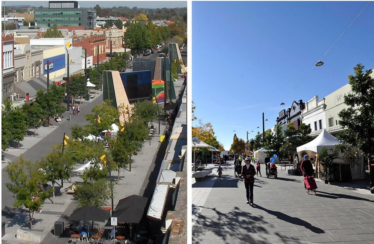
Obr. č. 9: Vtáčí pohľad na outdoorový obchodný dom Hargreaves mall
