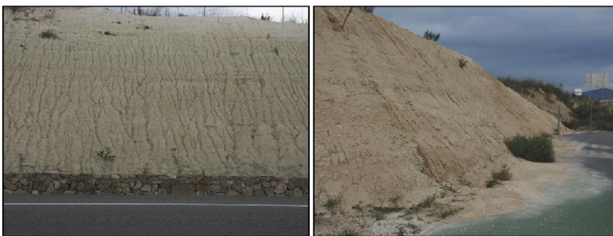
obrázek 6 Erozní procesy na nově zbudovaných svazích (Cerdà, 2007)
