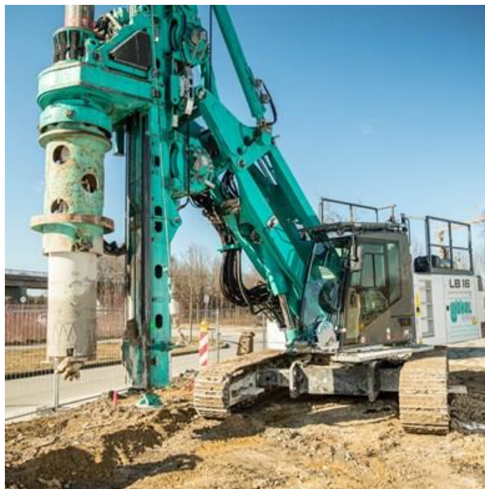
Obrázek 72: Vrtná souprava Liebherr LB 16-180
