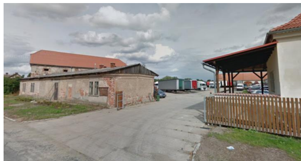
Obr. 81: Hospodářský dvůr Násedlnice
