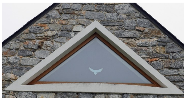
Obr. 19 Snímek upravovaného okna.
