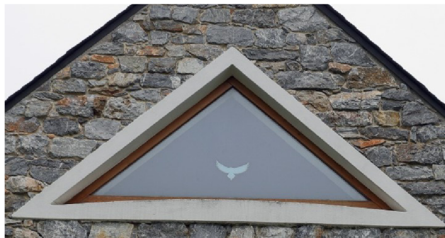
Obr. 19 Snímek upravovaného okna.
