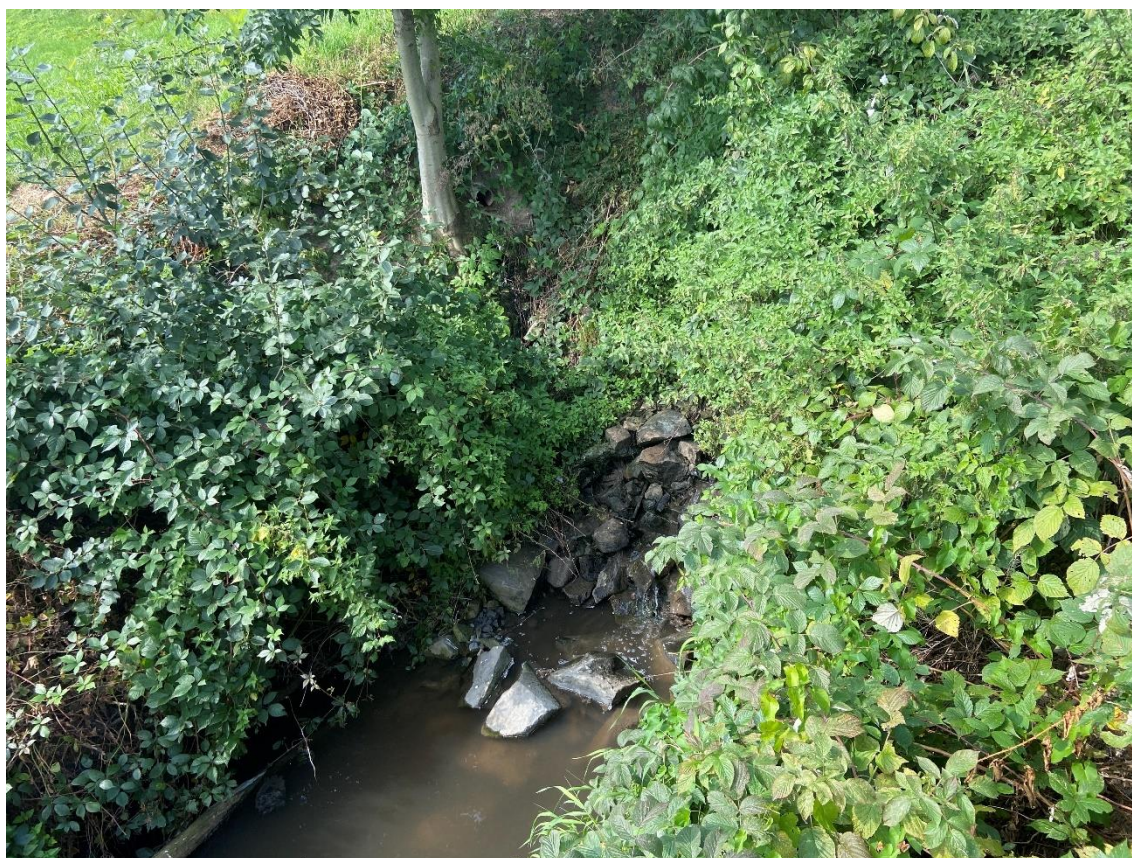
Obr. 7 - Prostor pod výústí jedné z mnoha vodotečí v obci Skřipov
