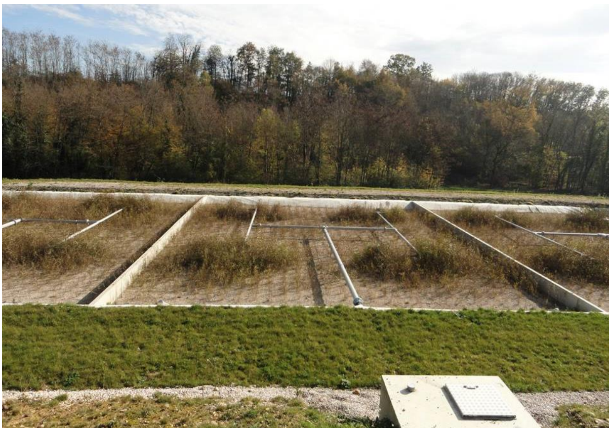
Obr. 15 - Distribuční potrubí: 1. stupeň (2) [18]
