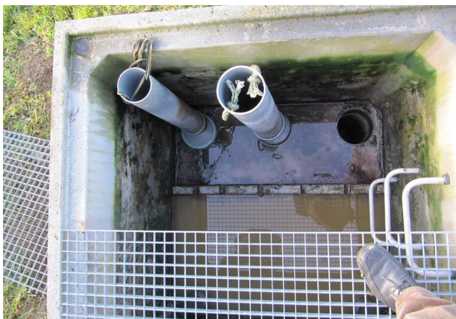
Obr. 32 - Rozdělovací nádrž pro první stupeň čištění [13]
