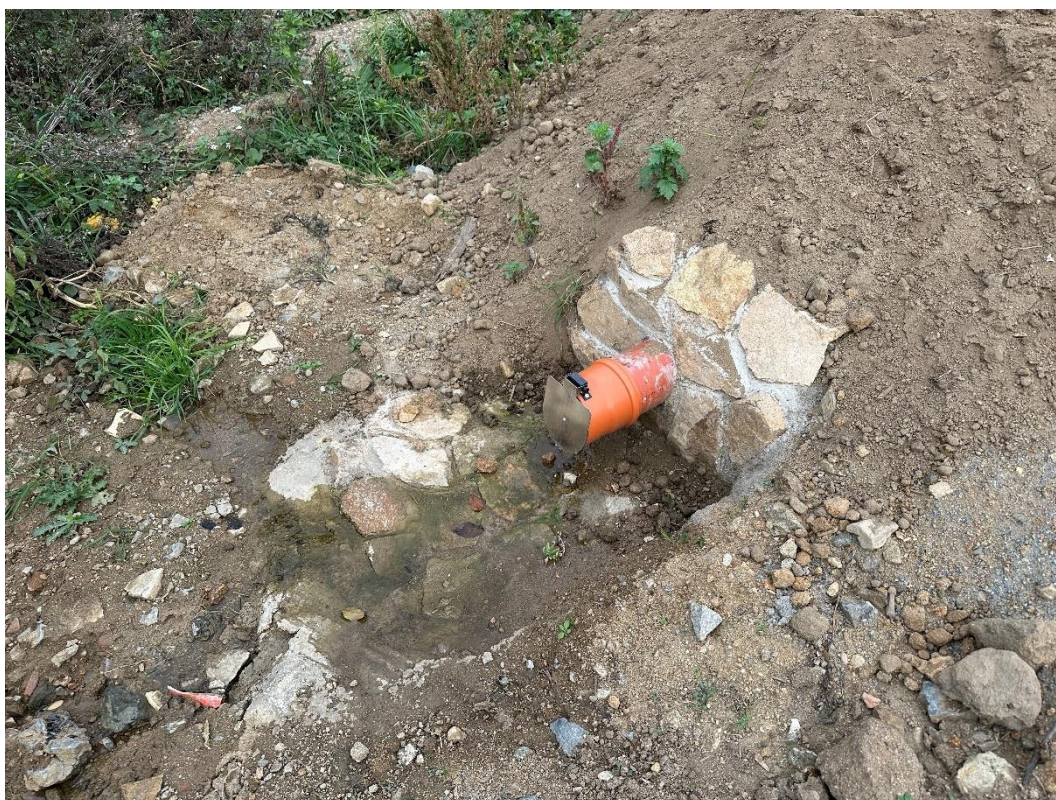
Obr. 35 – Výustní objekt, školní exkurze (obec Hlína)
