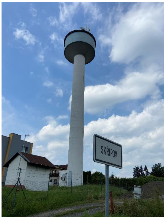
Obr. 5 - Vodojem v obci Skřipov
