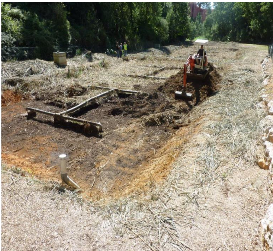
Obr. 20 - Odstraňování kalové vrstvy z prvního stupně čištění FS v Roussillonu ve Francii po 13 letech provozu [4]
