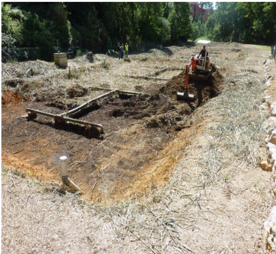
Obr. 20 - Odstraňování kalové vrstvy z prvního stupně čištění FS v Roussillonu ve Francii po 13 letech provozu [4]
