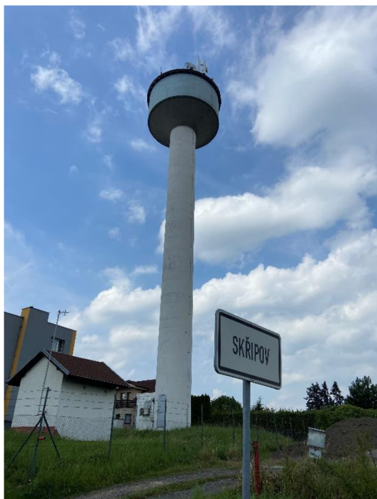
Obr. 5 - Vodojem v obci Skřipov
