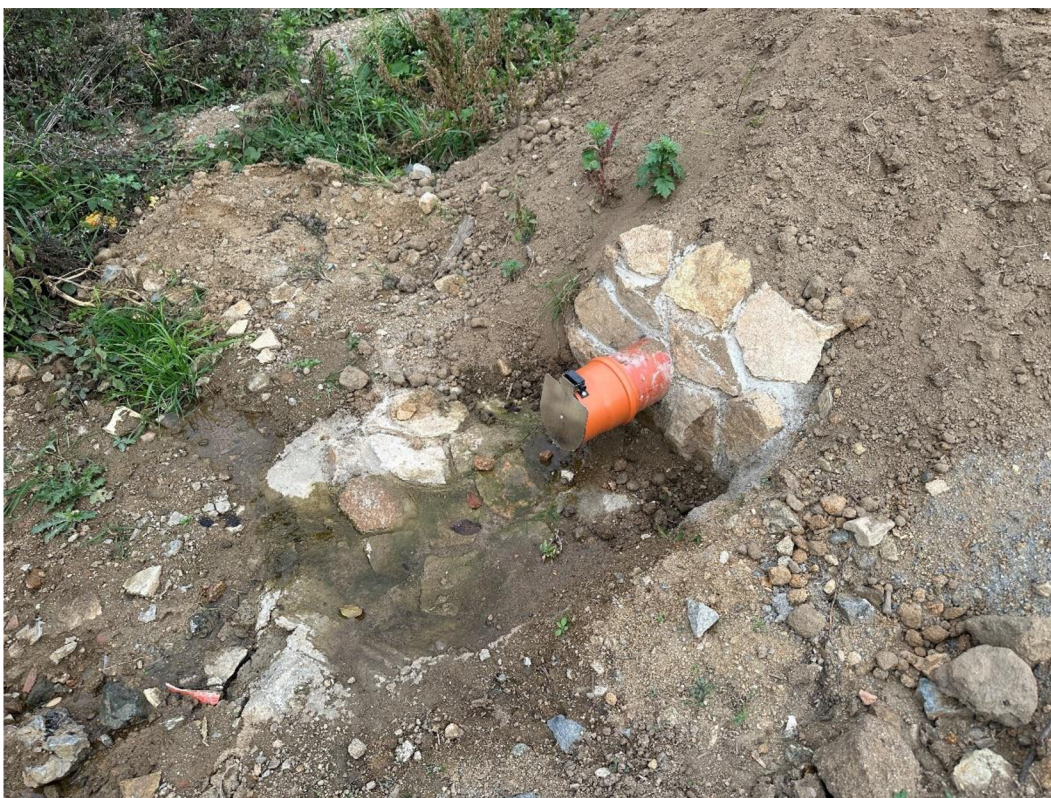
Obr. 35 – Výustní objekt, školní exkurze (obec Hlína)
