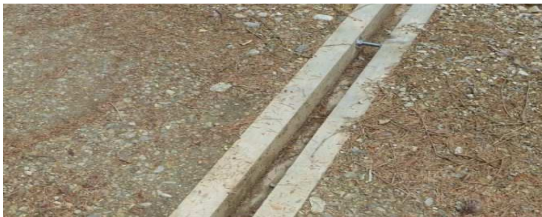
Obrázek č. 3 – Detail dřevěné svodnice – foto Martin Váško
