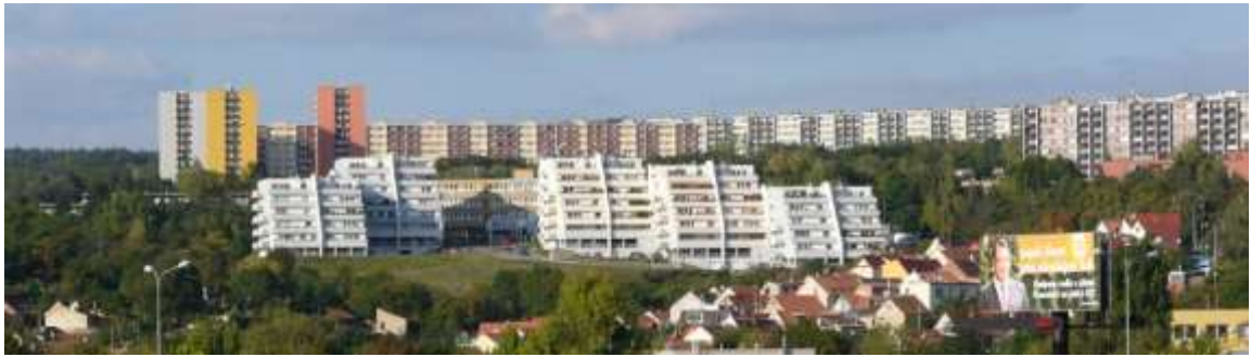
Obr. č. 68 – Pohľad na domy v Tomečkovej ulici (17)
