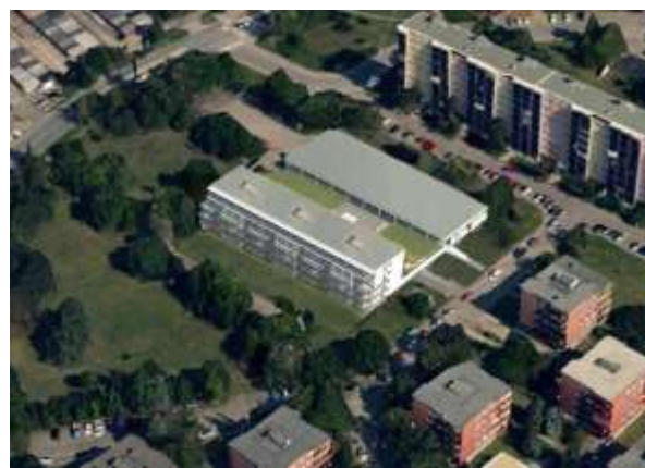
Obr. č. 73 - Polyfunkčný dom Obzor a jeho hmotové riešenie (18)
