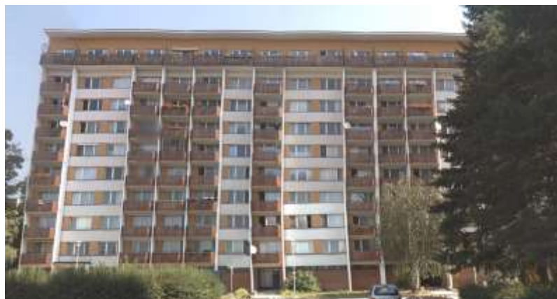
Obr. č. 55 – Nástavba domu na ulici Heleny Malířové (5)
