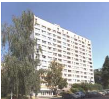
Obr. č. 39 – Vysokopodlažný dom (15)
