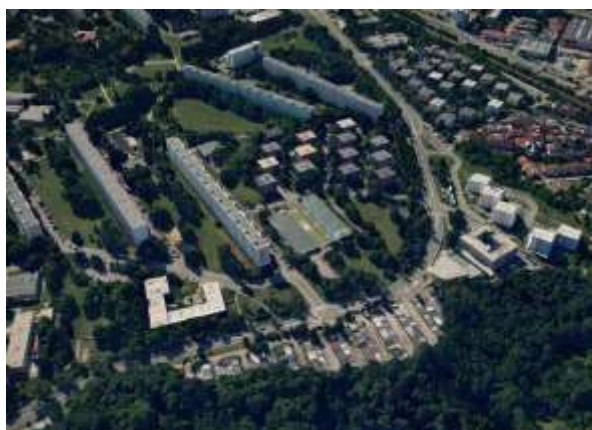
Obr. č. 72 - Polyfunkčný dom Obzor v kontexte sídliska (18)
