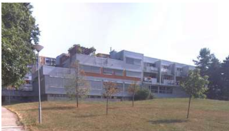
Obr. č. 61 – Pohľad na bytový dom Polana (15)
