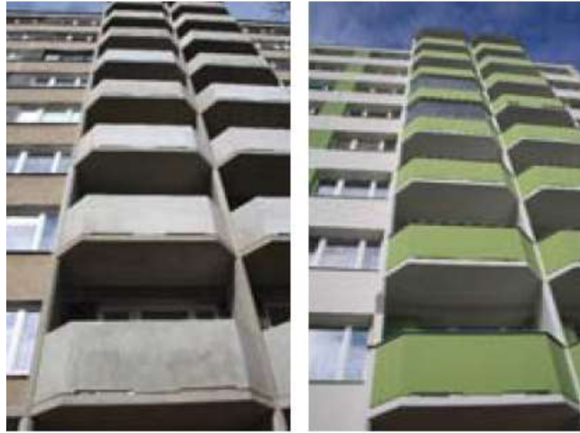
Obr. č. 56 – Nové lodžie pred a po povrchovej úprave (13, s. 165)
