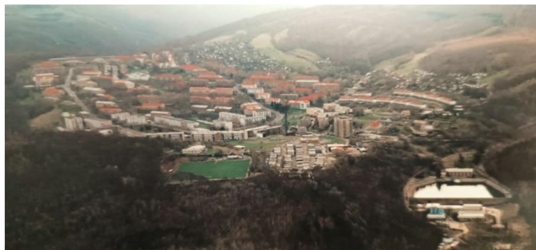
Obrázek 10 - Letecký pohled, pohled na město od východu, v popředí úpravná pitné vody
