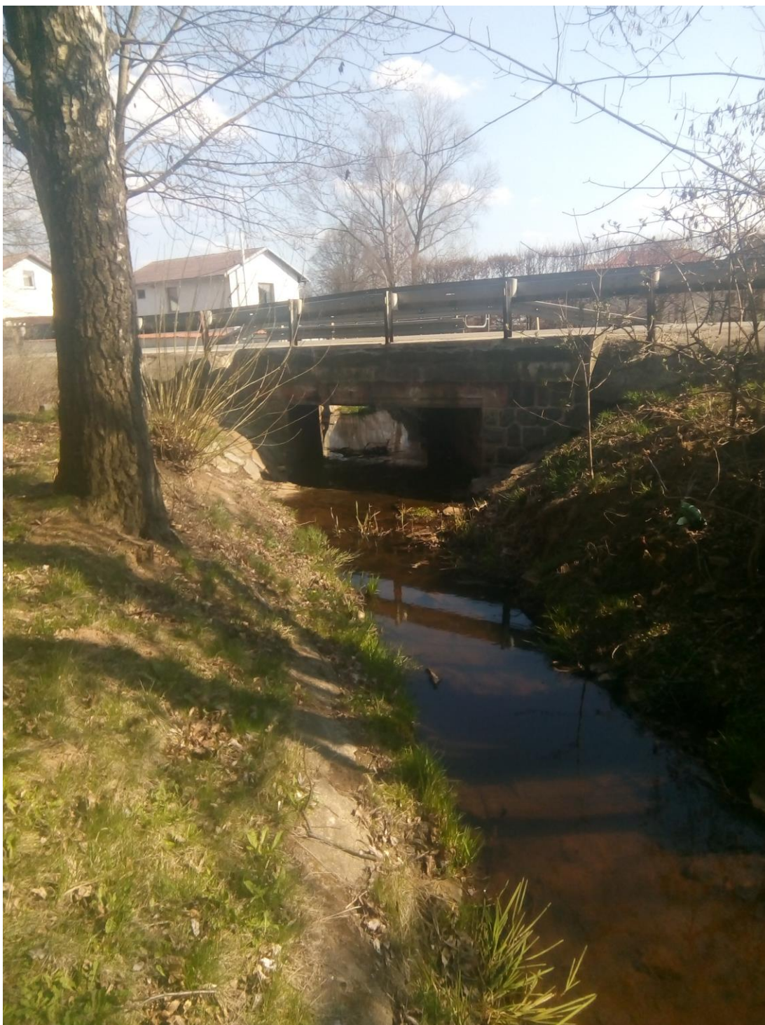
Obrázek č. 9 - propustek v obci Nové Homole
