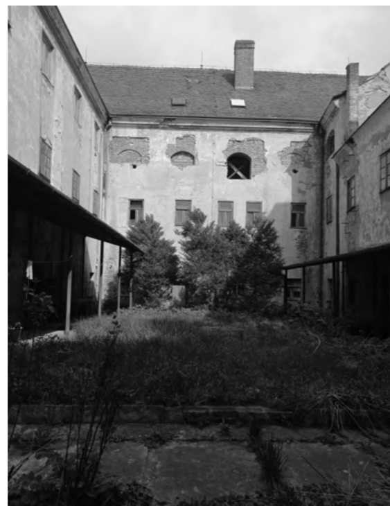
Obr.34 vlastní foto rajská zahrada, pohled směrem od kostela
