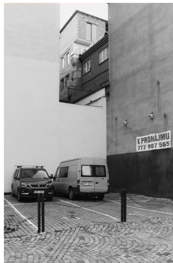
Obr.05 vlastní foto slepé fasády, odvrácená strana
