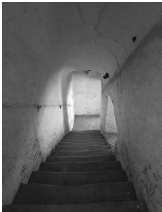
Obr.36 vlastní foto pohled na schodiště v jižní části kláštera
