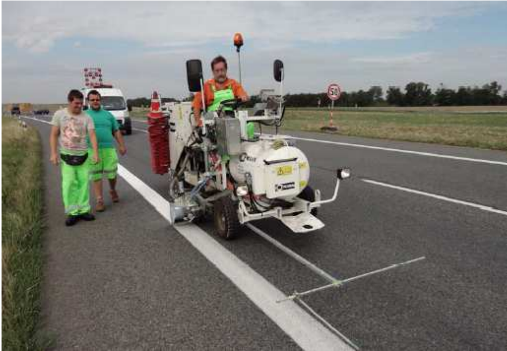
Obrázek 20: Pokládka vodorovného dopravního značení [24]
