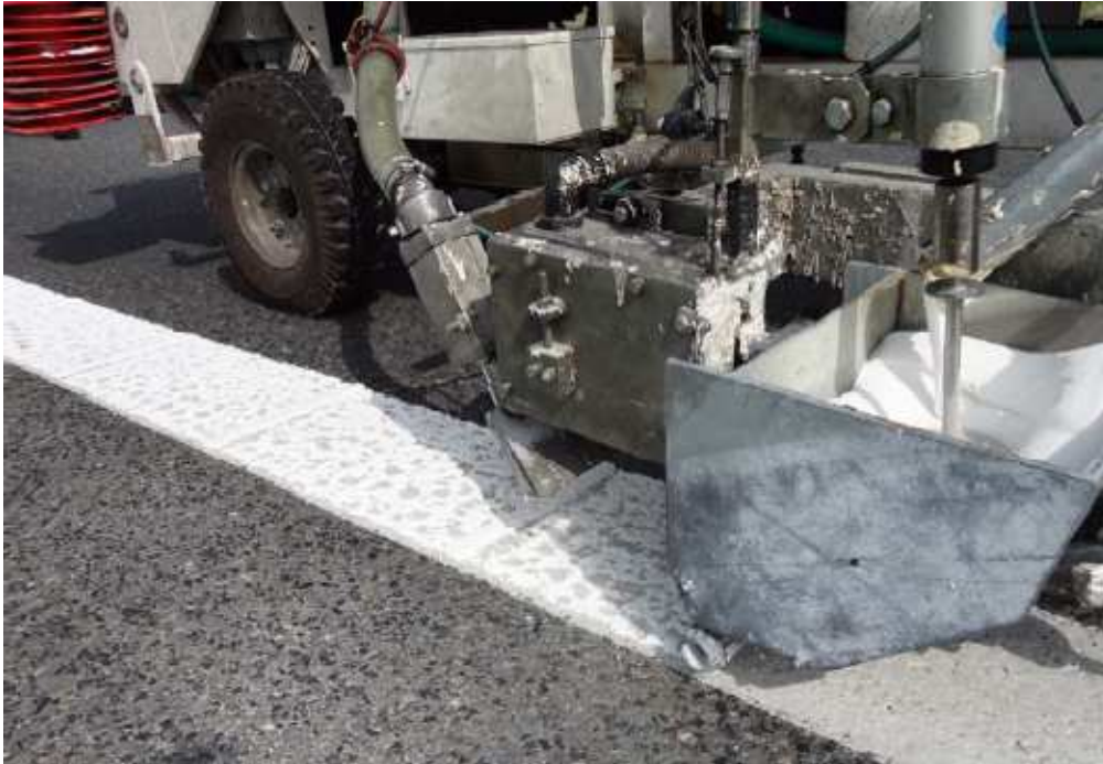
Obrázek 22: Pokládka vodorovného dopravního značení [24]
